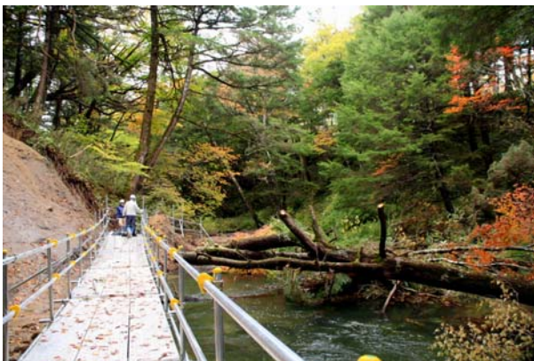
10/12 湯川浴い 仮設歩道
