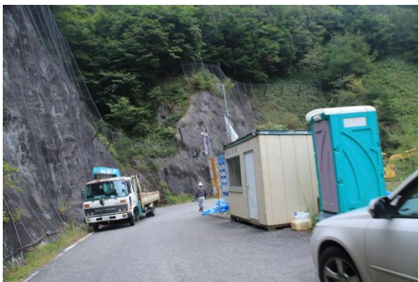
9/14 山王林道開通 (工事は続き道幅狭い)
